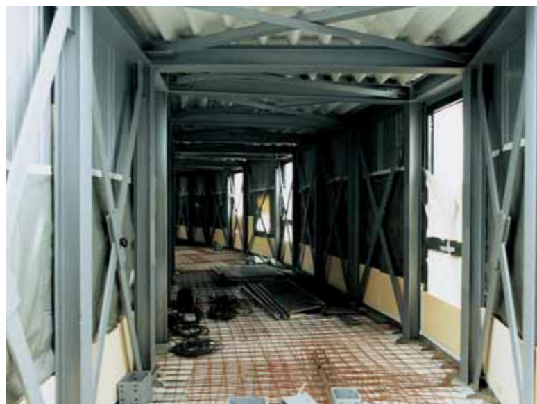
Die Stahlkonstruktion der Brücke in S-Form stellt sich als räumliches Fachwerk dar (Bild links). 32 Schrauben verankern jeweils die beiden 19 Meter hohen Stützen (Bild oben) im Fundament. Der Pylonfuß hat einen Durchmesser von 1,75 Metern, am Auflagerkranz misst die zehn Tonnen schwere Stahlsäule 0,90 Meter.
