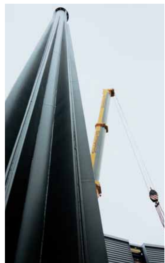
Die Stahlkonstruktion der Brücke in S-Form stellt sich als räumliches Fachwerk dar (Bild links). 32 Schrauben verankern jeweils die beiden 19 Meter hohen Stützen (Bild oben) im Fundament. Der Pylonfuß hat einen Durchmesser von 1,75 Metern, am Auflagerkranz misst die zehn Tonnen schwere Stahlsäule 0,90 Meter.
