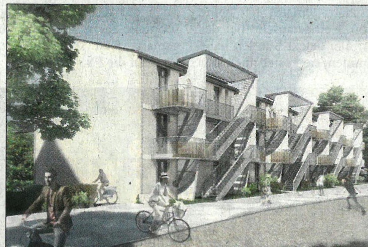
Durch die außenliegenden Treppenhäuser werden erhebliche Kosten gespart. Simulation: Schneider+Schumacher
